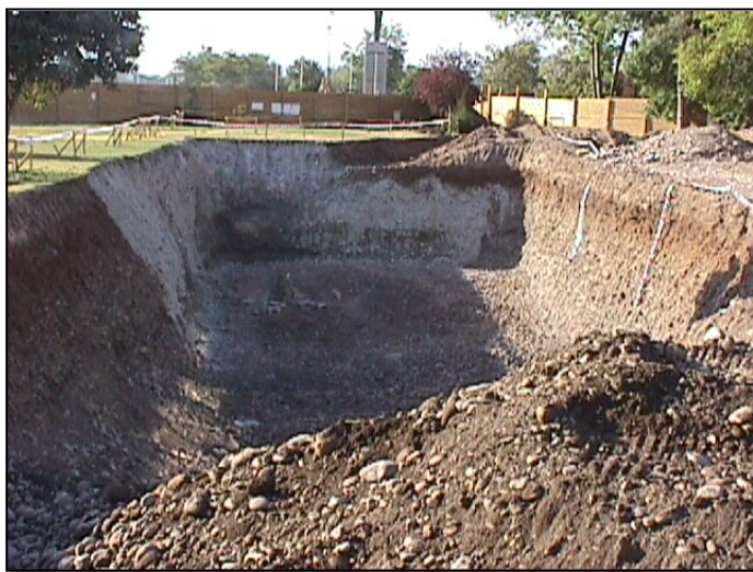
Figura 1.12 Fotografía de una excavación.
