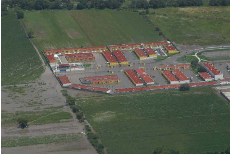
Figura 1.4 Fraccionamiento al poniente de la Cd. De Querétaro inundado después de unas torrenciales lluvias.
