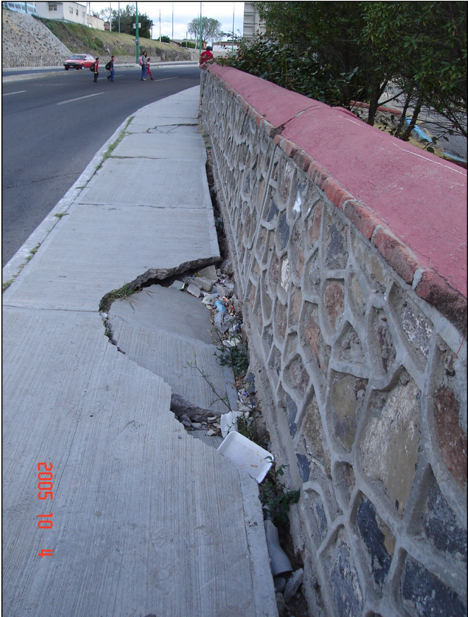
Figura 1.11 Inestabilidad del talud en la vialidad Boulevard de las Américas, frente al parque hundido en la ciudad de Querétaro
