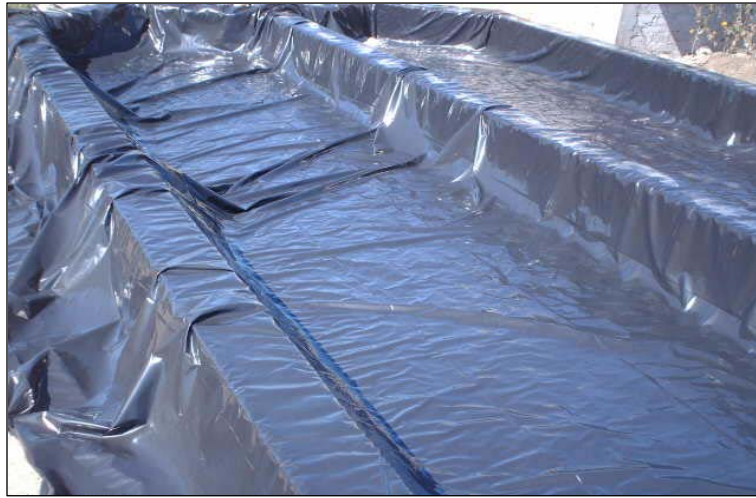
Figura 4.1. Colocación de membrana de polietileno calibre 600 en las parcelas de evaluación.
