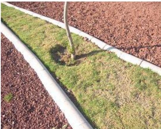
**Figura 5.15** Jardinera delimitada por medio de cilindros de concreto.
