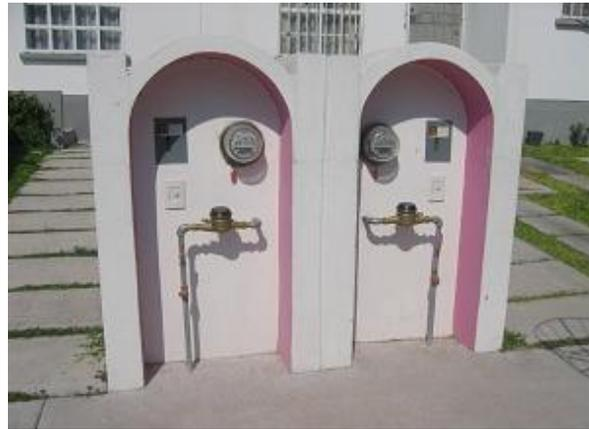
**Figura 5.11** Muretes de CEA y CFE, contruidos empleando trozos de varilla y diferentes residuos de concreto.
