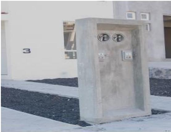
**Figura 5.10** Murete realizado con trozos de armex de acero.
