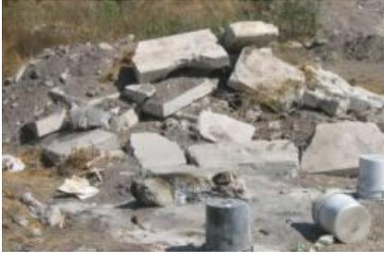
**Figura 4.33** *MROC generado por la demolición del CRIQ, Querétaro.*
