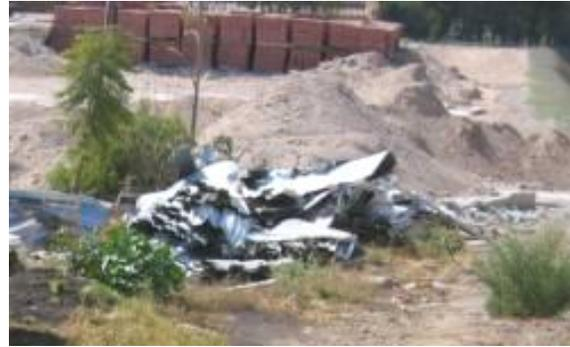
**Figura 4.37** *Techos y tierras generadas por la demolición del CRIQ.*
