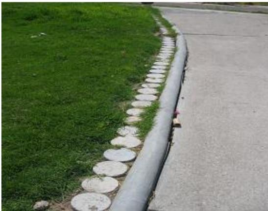
**Figura 5.13** Área verde delimitada con cilindros de concreto enterrados alrededor de la zona.
