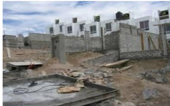
**Figura 4.14** *Sistema constructivo por medio de muros de tabicón blanco.*
