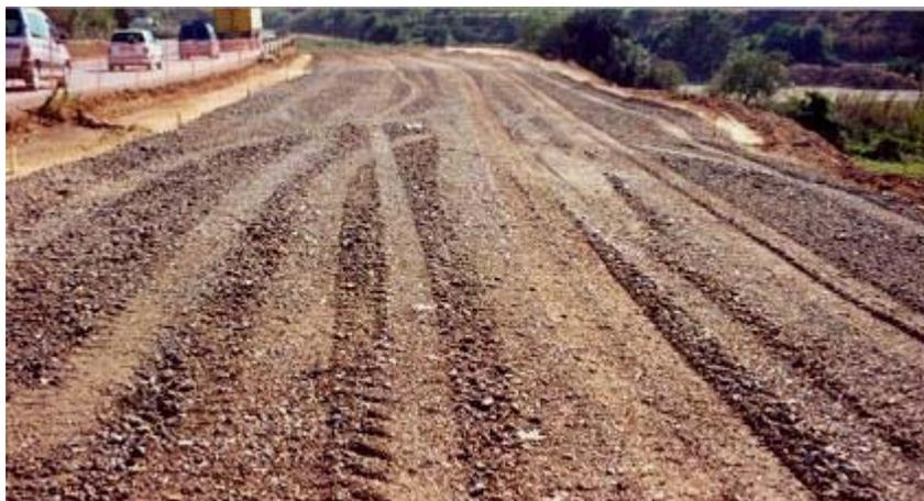
**Figura 5.34** *MROC reciclados por medio del método de trituración, utilizado como sub-base en carreteras.*
