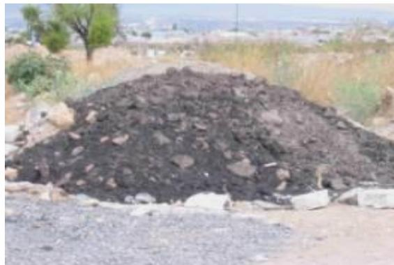
**Figura 4.29** Tierras negras producto de excavación, generados en el proceso constructivo.
