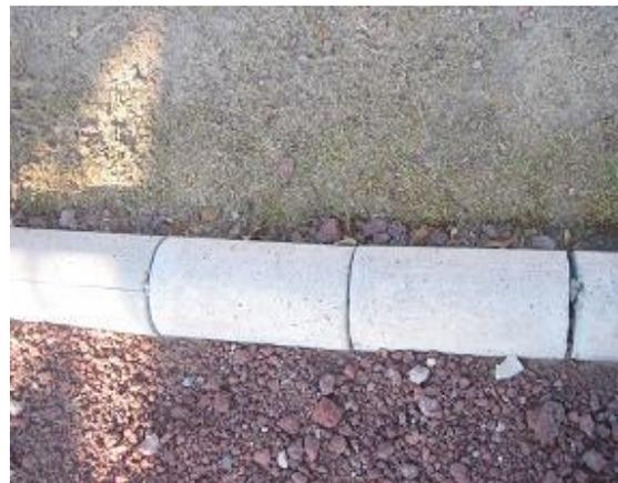
**Figura 5.16** Limite entre dos diferentes áreas por medio de cilindros de concretos.
