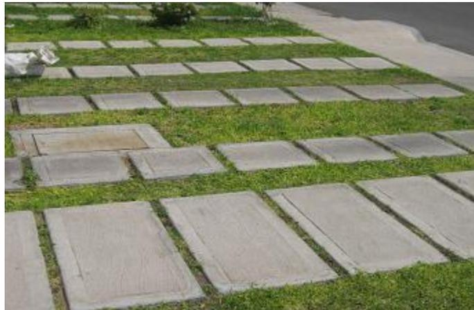
**Figura 5.12** Aprovechamiento de los residuos de concreto, generados en las diferentes actividades ejecutadas en obra.
