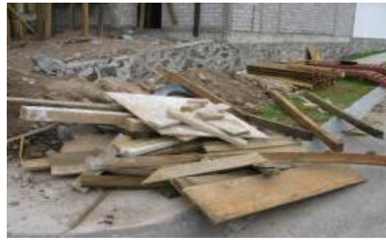
**Figura 4.27** Separación de maderas contenidas en los MROC recolectados.
