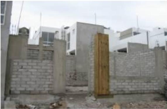
**Figura 4.15** Sistema constructivo en cadenas y castillo
