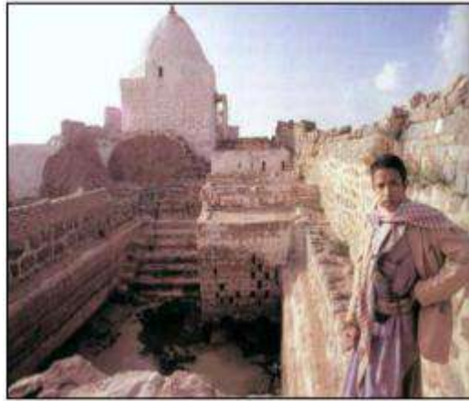
Figura. 2.1 CISTERNA A CIELO ABIERTO PARA LA RECOLECCION DE AGUA DE LLUVIA EN YEMEN. (Historia de los sistemas de aprovechamiento del agua de lluvia, Colombia 2006)
