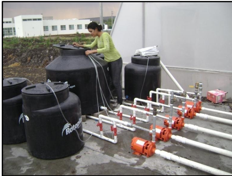
Figura 4. 10.- Instalación de actuadores
