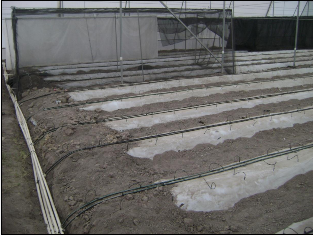
Figura 4. 12.- Líneas de riego
