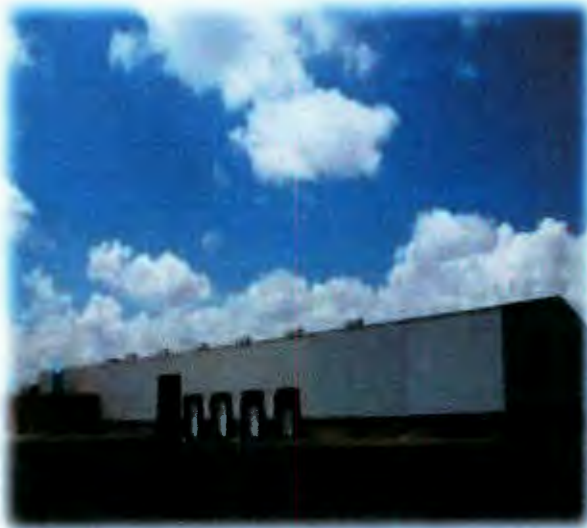
Figura 5. Exterior de la planta empacadora.
