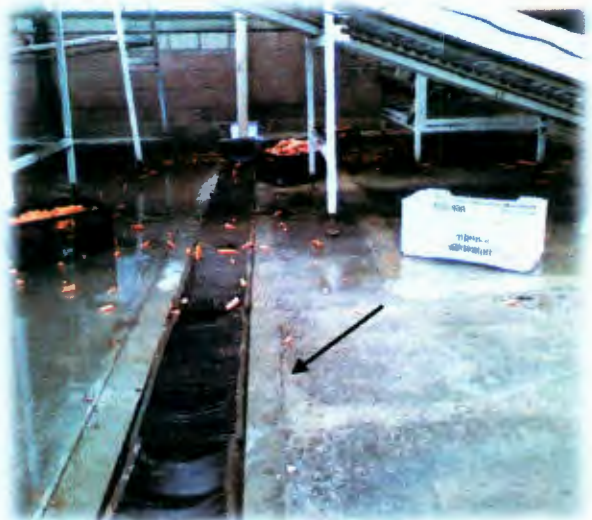
Figura 8. Deficiencias en la rejilla de drenaje.
