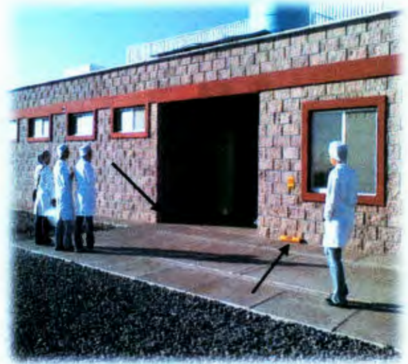
Figura 6. Entrada de acceso con sus respectivas trampas contra roedores.
