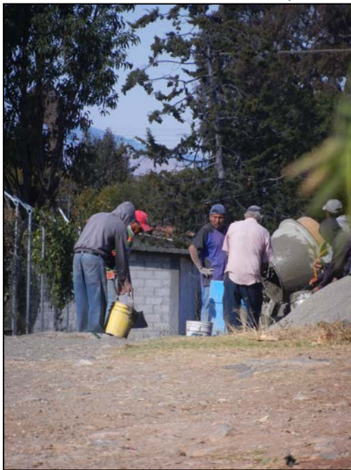
Trabajo en construcción y en la parcela.
