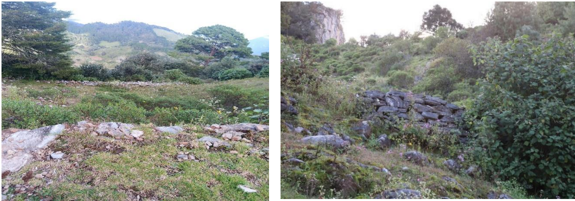
Figura 46. Presas de piedra acomodada en la localidad de Llano de San Francisco.
