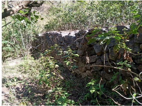
Figura 48. Presa de piedra acomodada en la localidad de Agua Amarga.
