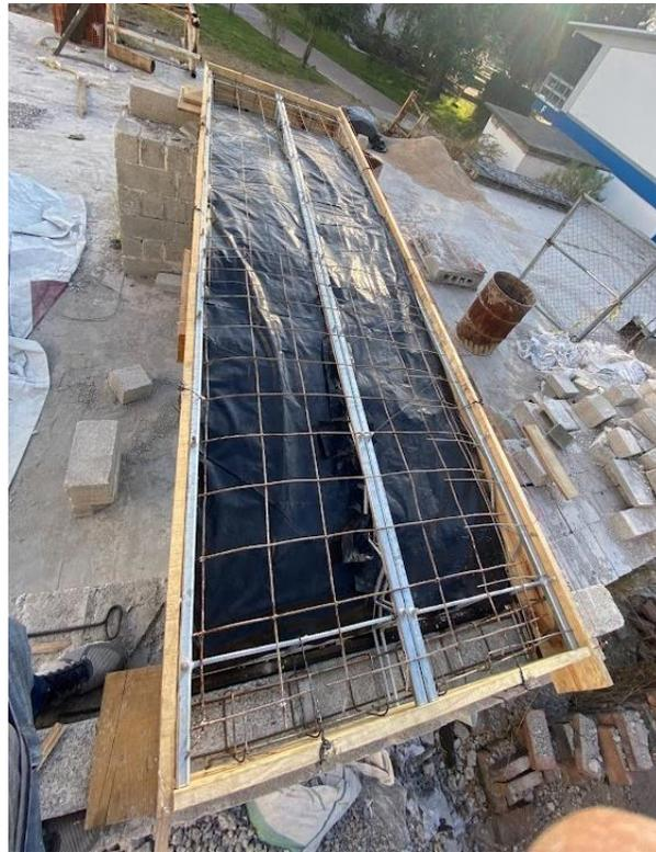
*Figura 2.8 Módulos de LMA cimbrados con malla electrosoldada.*
