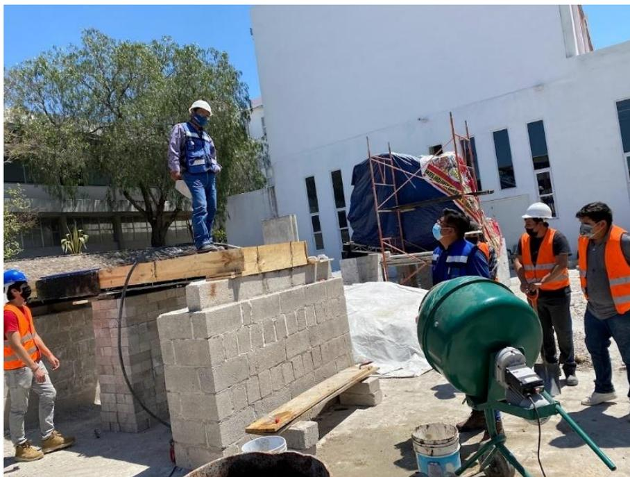
*Figura 2.9 Proceso de colado de losa de concreto*
