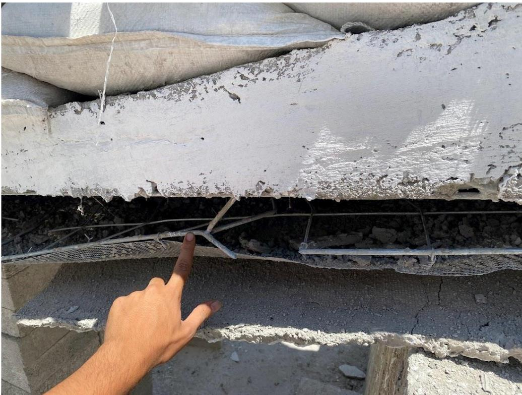
*Figura 5.21 Detalle de elementos que fallaron al colapso del sistema*
