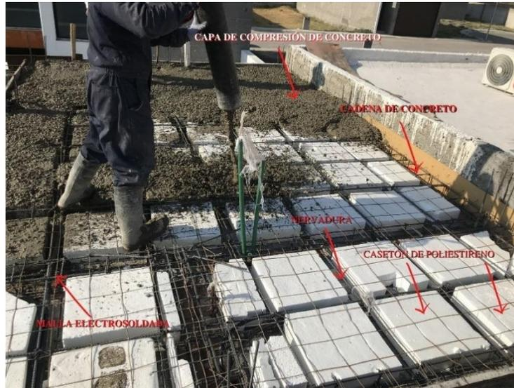
*Figura 1.5 Losa reticular componentes*
