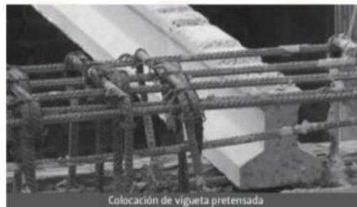
Figura 1.22 Tipos de viguetas prefabricadas de concreto (PREMEX, 2013)
