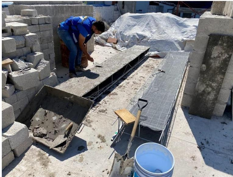
*Figura 2.5 Colocación de primera capa del acabado inferior de la LMA*
