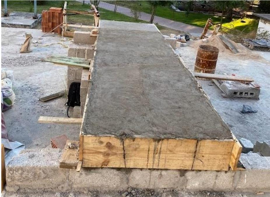
*Figura 2.10 Proceso de acabado de parte superior de losa de concreto*
