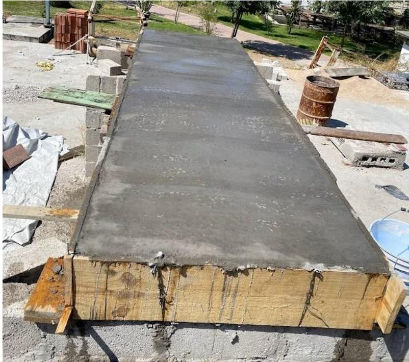
*Figura 2.12 Proceso de curado de losa de concreto*
