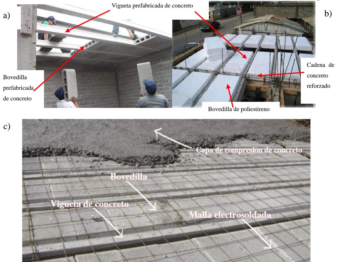
Figura 1.21 a) b) c) Componentes Vigueta y Bovedilla
