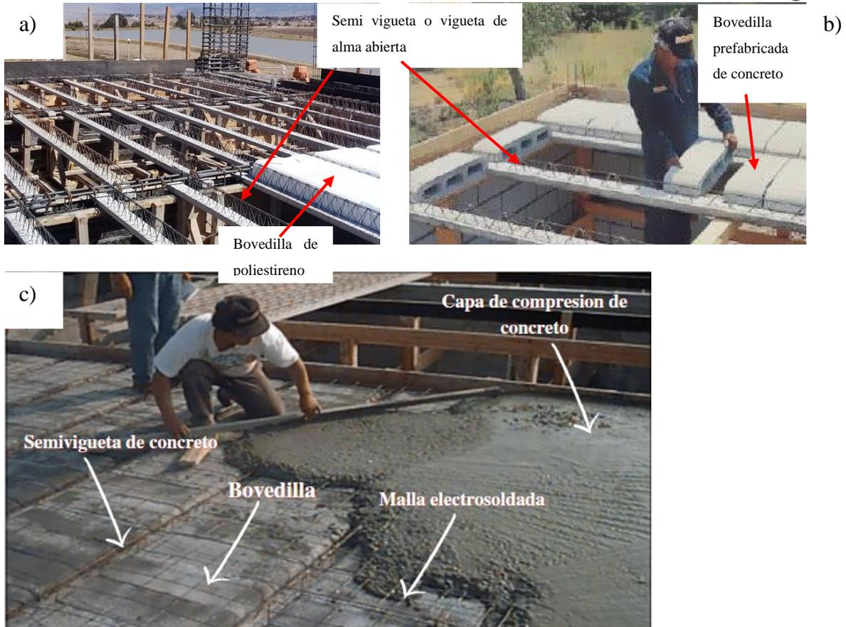
Figura 1.23 a), b) c) Componentes de vigueta de alma abierta o semivigueta y bovedilla
