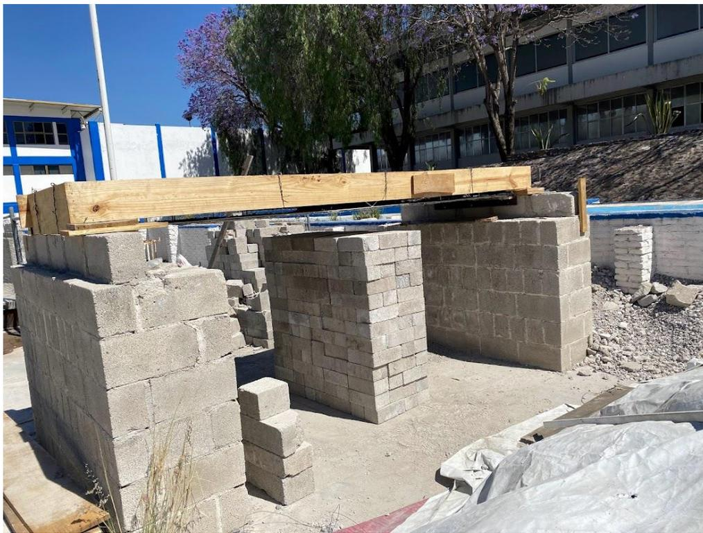
*Figura 2.7 Cimbrado del sistema LMA*
