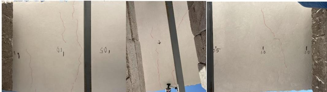
Figura 5.5 Grietas en acabado de parte inferior
