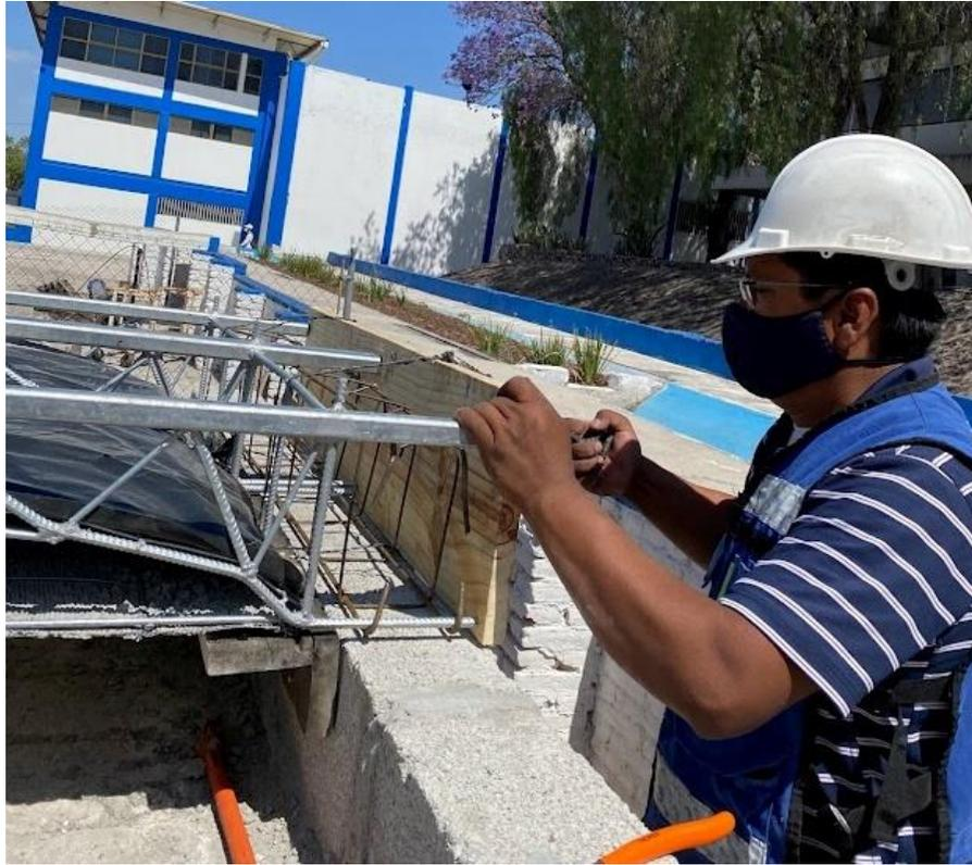
*Figura 2.6 Catillo Armex y cimbrado de cadena de concreto*
