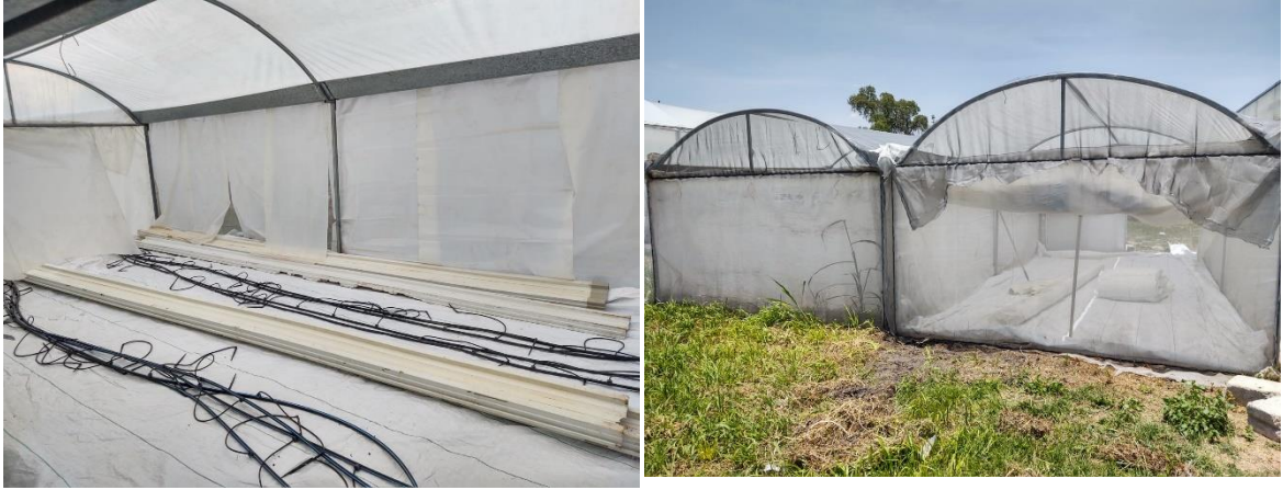
Figura 4. Invernadero acondicionado y limpio
