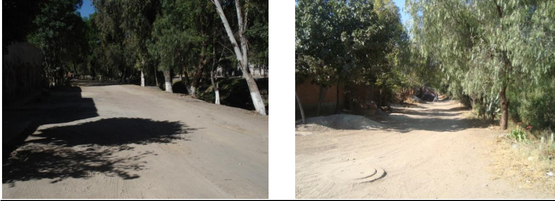
Ilustración 42 y 43. Estado Actual de la Vialidad a Modernizar
