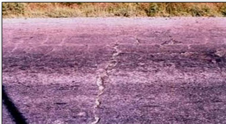
**Imagen 5. Fisuras y Grietas Transversales**
