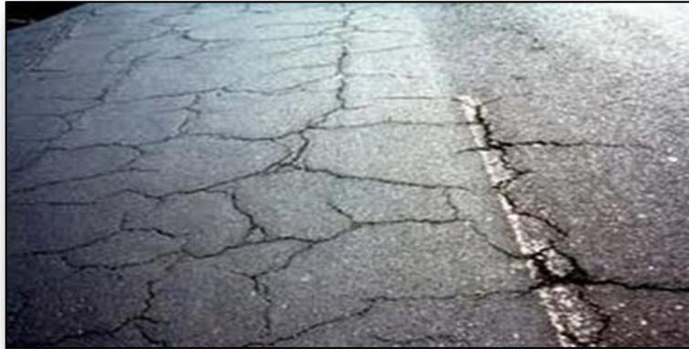
**Imagen 3. Fisuras y Grietas en Bloque**
