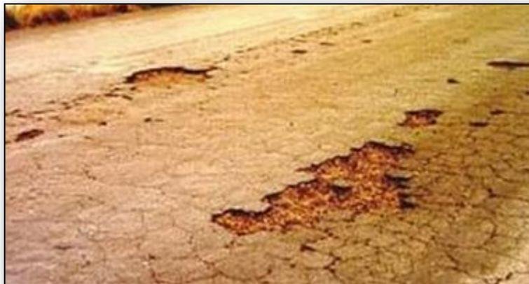
**Imagen 2. Fisuras y Grietas por Fatigamiento**
