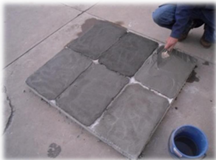
Figura 3.31.- Revestimiento de las losas.
