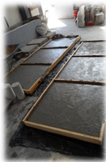
Figura 3.30.- Losas para pruebas de adherencia terminadas.
