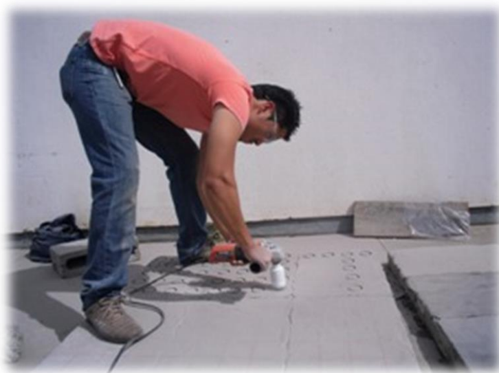
Figura 3.40.- Perforación de losas para pruebas de revestimiento.
