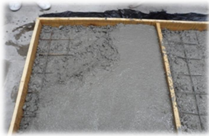
Figura 3.29.- Elaboración de la losa con malla electro soldada.
