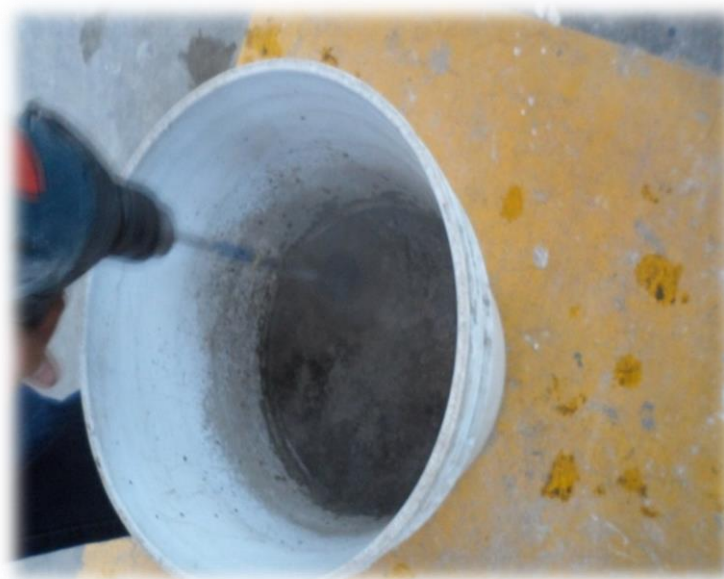
Figura 3.22.- Mezclado de los elementos para lograr un mortero.
