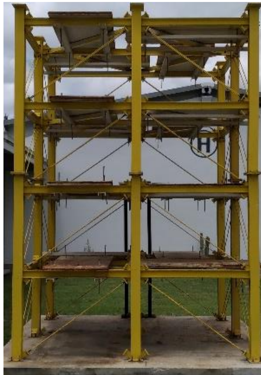
Figura 3.1. Estructura de acero con la que se trabaja.
