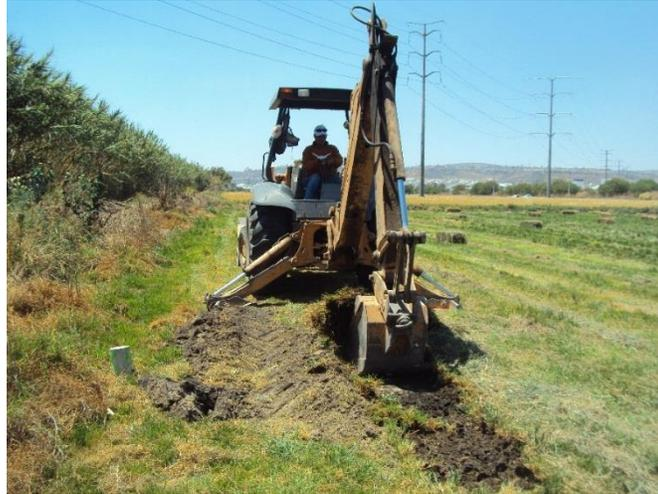
*Figura 3.4 Vista de Realización de Sondeo con Medios Mecánicos (PCA-1)*
