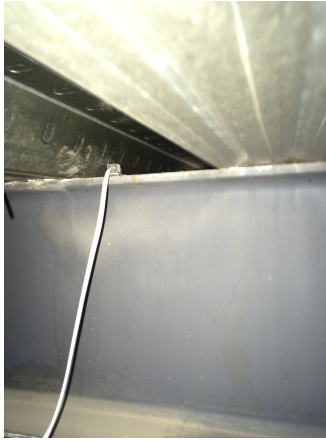
Figura 4.12: Colocación del sensor 1 del DAS1.
