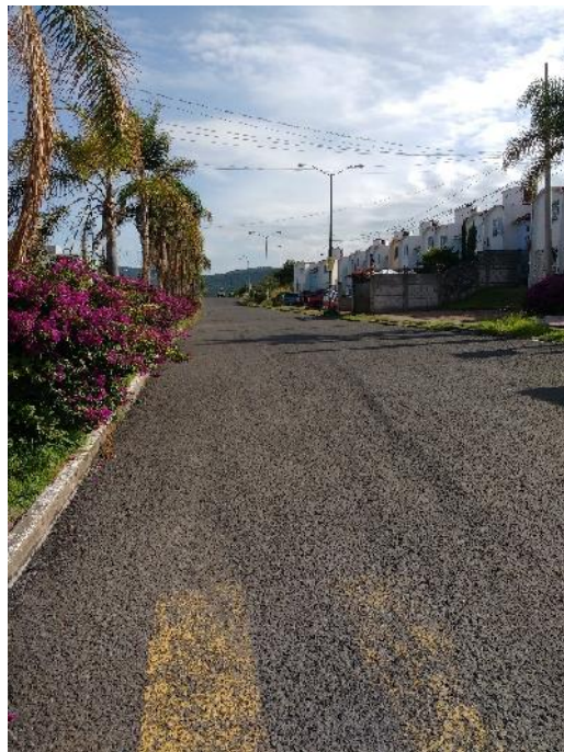
Fotografía 2. Zona que aporta caudal a la entrada mencionada en la fotografía 1
