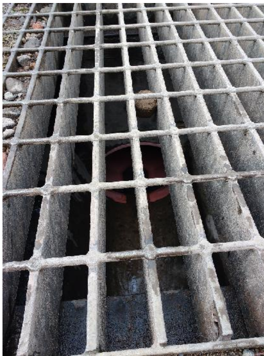
Fotografía 4. Dirección de la tubería aportante en la salida de la cuenca (Calle Industriales y Río Blanco).
