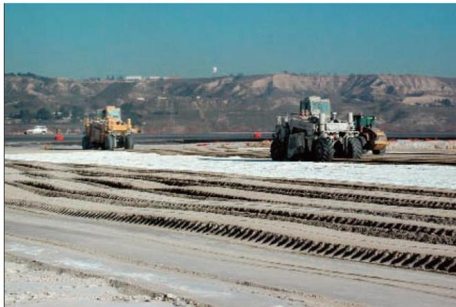
Figura 2-4. Estabilización con cal.
