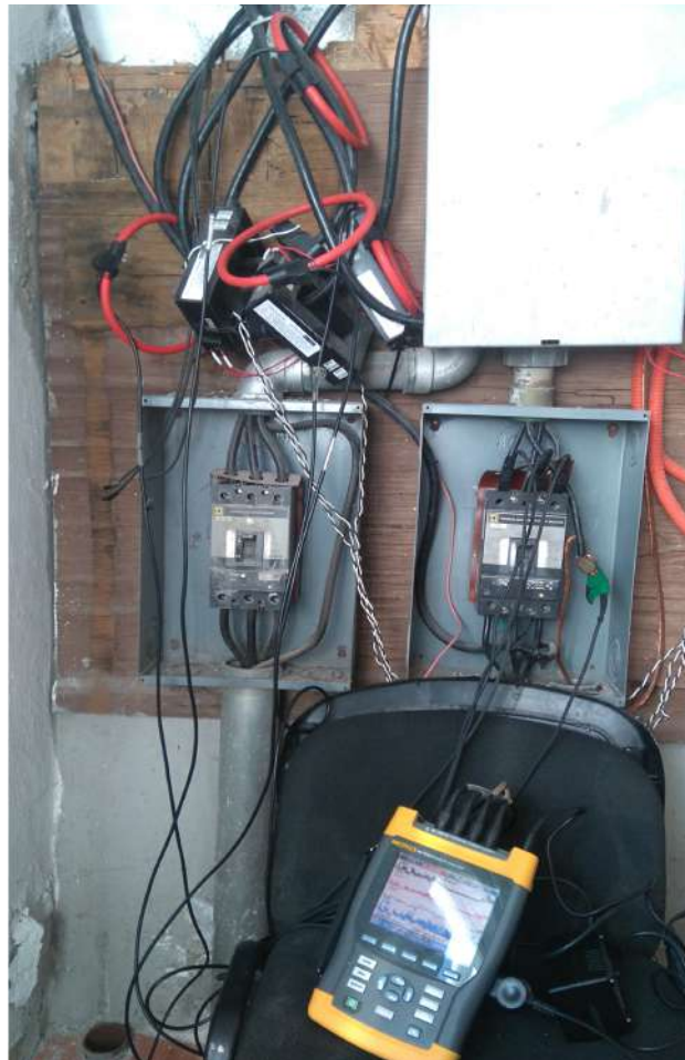
Figura 3.3: Conexiones para la medición.
