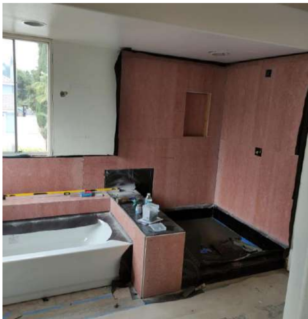
Fotografía 2: Remodelación de baño colocación de material aislante de agua (2021).
