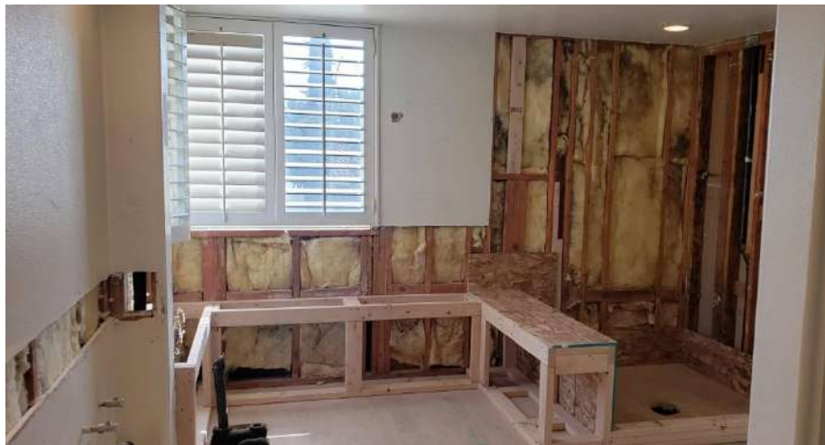
Fotografía 1: Remodelación completa de baño en recámara principal (2021).
