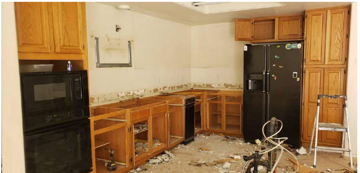
Fotografía 4: Demolición de cocina (2021).
