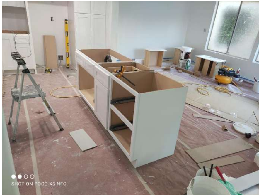
Fotografía 5: Armado y colocación de muebles y gabinetes (2021).
