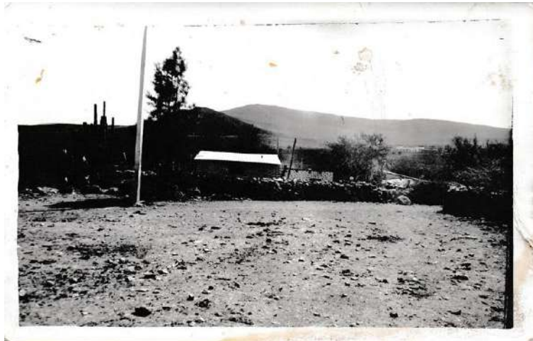
Fotografía 3. Hasta hace algunos años los muros de piedra seca conocidos como tecorrales o albarradas predominaban como sistema constructivo en la localidad. Archivo de Aurelio Hernández Reséndiz.
