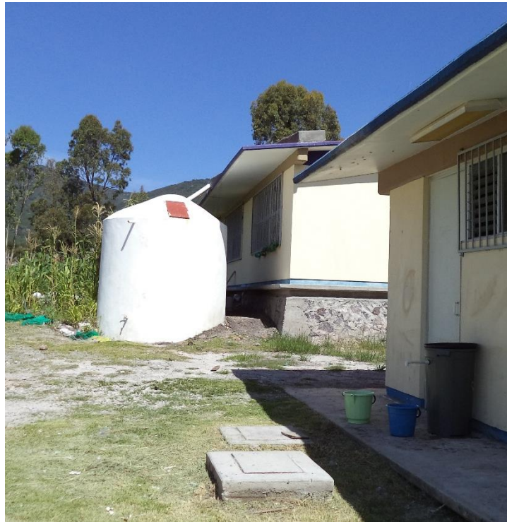
Figura 4-1. Cisterna de ferrocemento y biofiltro localizados en Pie de Gallo, Querétaro (fotografía tomada el 1 de agosto de 2013).
