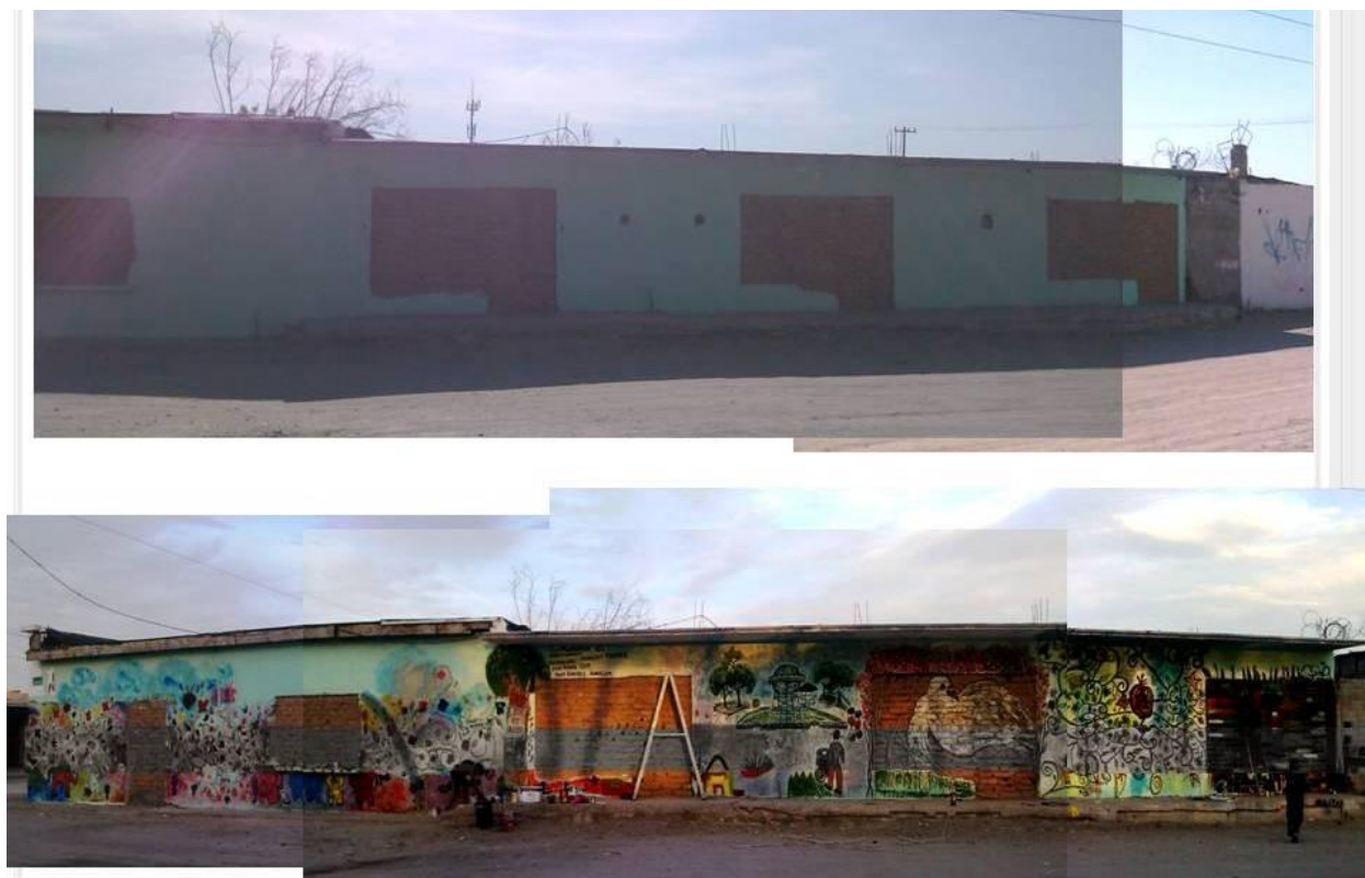
Fotografía 3: Pinta de murales en la zona afectada.
