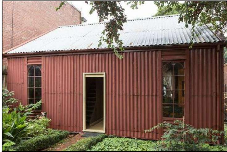
**Figura 3.** Sistema prefabricado de vivienda de Bellhouse manufacturada en Manchester, Inglaterra y construida en Melbourne, Australia en 1854 (NTA, 2019).
