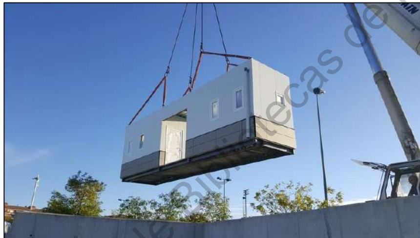
**Figura 13.** Sistema modular prefabricado (NSM-1, 2016).
