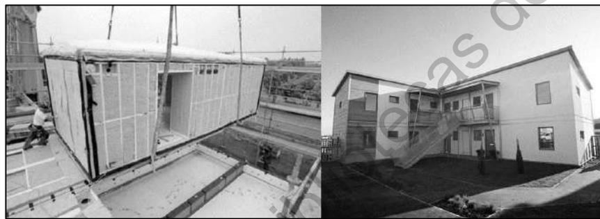
**Figura 5.** Sistema prefabricado de vivienda «Blok Lock» de la compañía IKEA (Smith, 2009).
