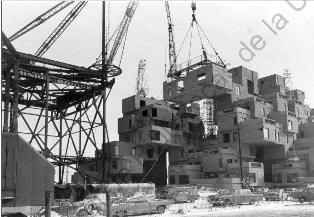
**Figura 7.** Construcción en 1967 del proyecto «*Habitat 67*» de módulos prefabricados (Speaman, 1967).
