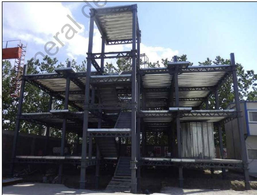
**Figura 56.** Edificio experimental construido con el sistema modular de entresijos con armaduras conectadas a las conexiones universales (X.C. Liu et. al., 2015).
