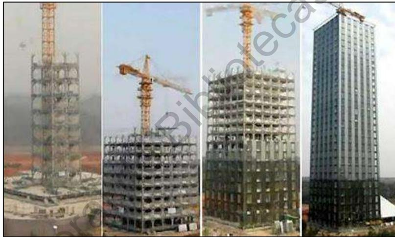
**Figura 43.** Edificio «T-30» en distintas etapas de la construcción durante 15 días (BSB, 2012).
