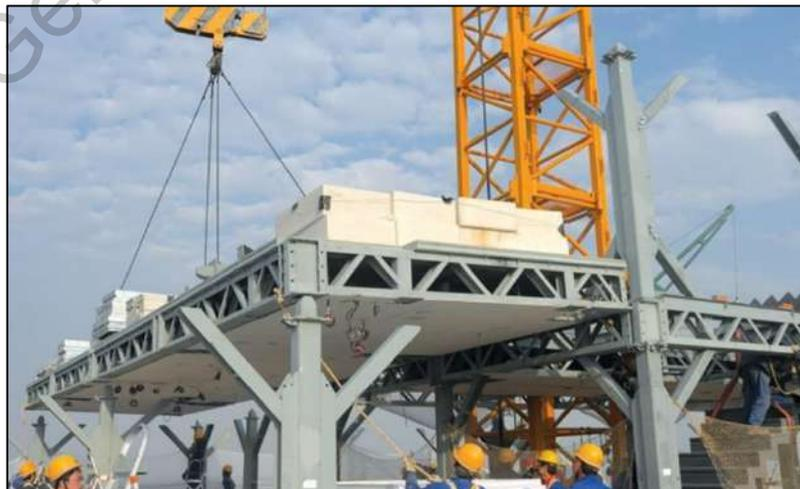
**Figura 44.** Ensamblaje del sistema modular de entresijo del edificio «T-30» (BSB, 2012).
