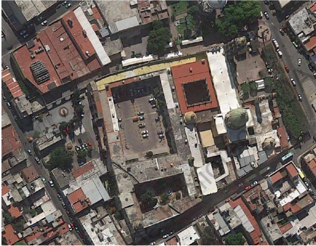
Fotografía 2.3: Vista aérea del convento de San Francisco de Celaya. Se observa claramente el corte que el INAH tuvo que realizar en el convento para evitar el desplome del mismo. Imagen tomada de Google.maps.
