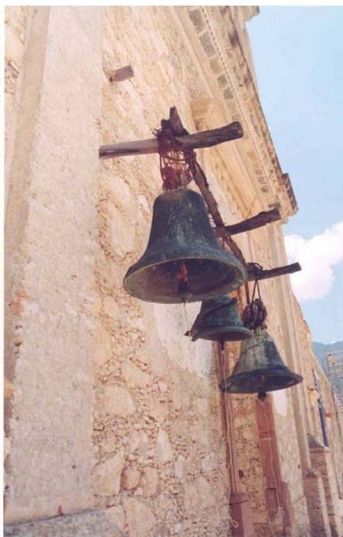
Foto 14. El “campanario” provisional colocado en la fachada del templo, para suplir el campanario que nunca se construyó.
