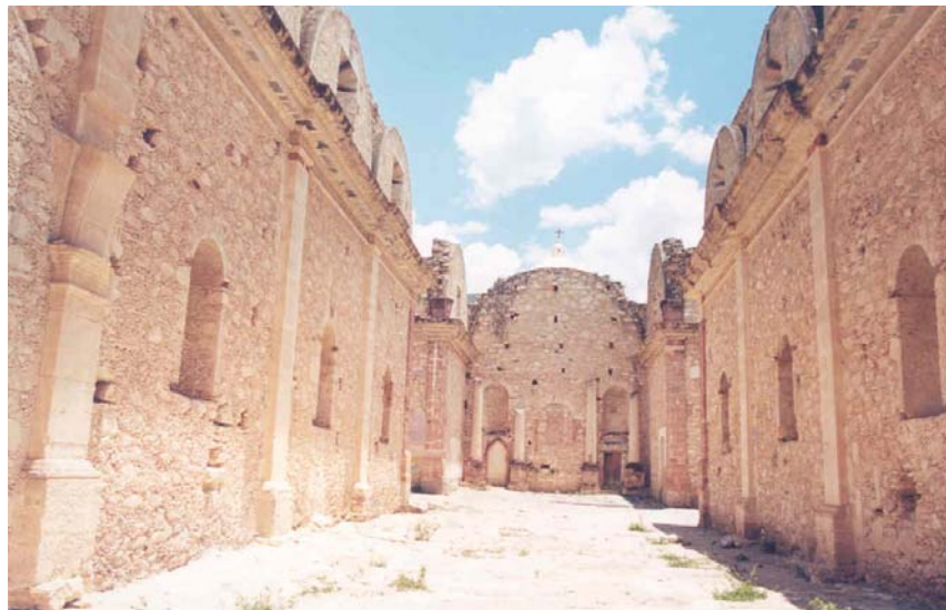
Foto 13. Tomada del interior del templo inconcluso de Bucareli, con las bardas laterales y frontal. El templo nunca se techó.
