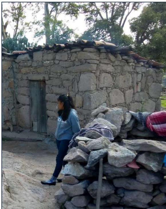
Figura 3, Aspecto de una parte de la vivienda
