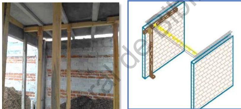
Figura 4. Colocación de semivigueta dentro de la trabe o cadena.
