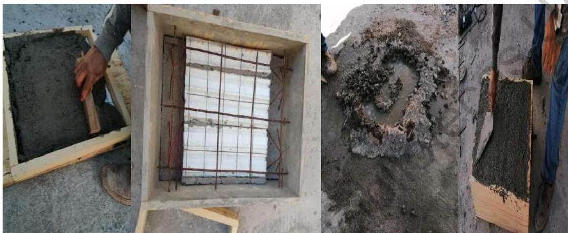
Figura 20. A) Repellado del panel W por una cara con mortero B) Colocación de malla electrosoldada C) Preparación de mezcla D) Colado de la muestra.
