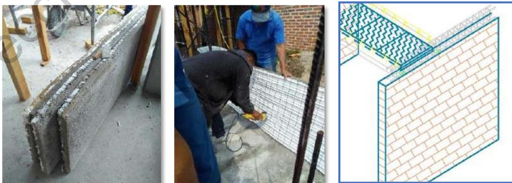
Figura 5. Corte del panel W repellado con mortero.
