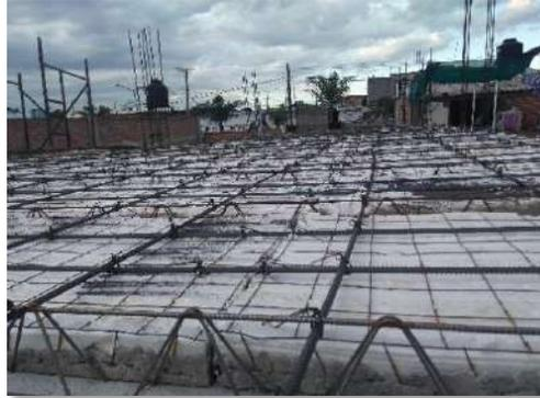
Figura 6. Colocación de malla electrosoldada.
