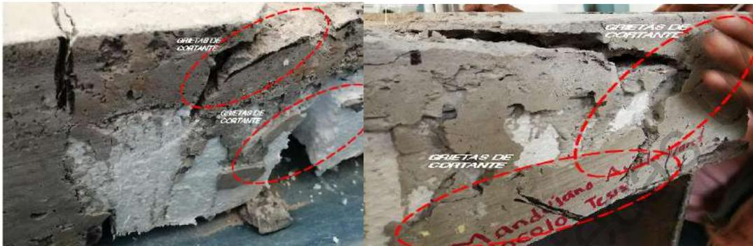
Figura 36. Patrón de grietas en cada claro de la losa Vigueta-Bovedilla.
