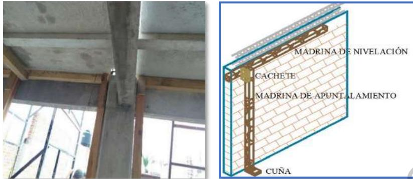
Figura 3. Apuntalamiento para losa Vigueta-Panel W.
