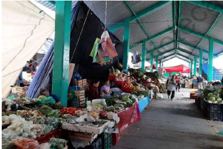
Fotografía 5: Techado I ubicado en la cabecera municipal
