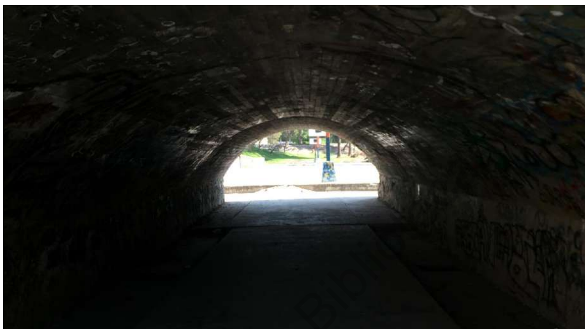
Fotografía 22. Túnel segunda y tercera zona: autoría propia (tomada en 2018-03-27).
