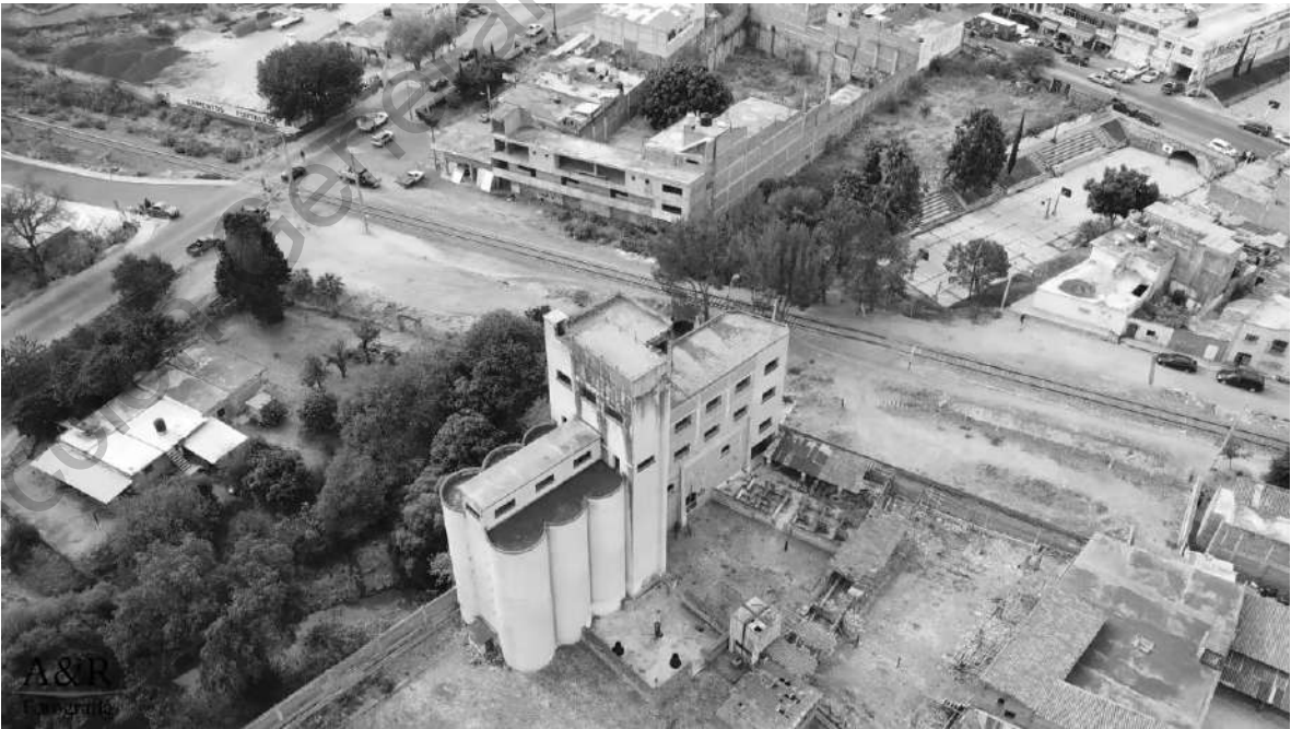
Fotografía 5. Molino y canchas: obtenida de video con dron A&R.
