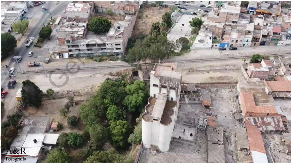
Fotografía 48. Molino y canchas: obtenida de video con dron A&R.
