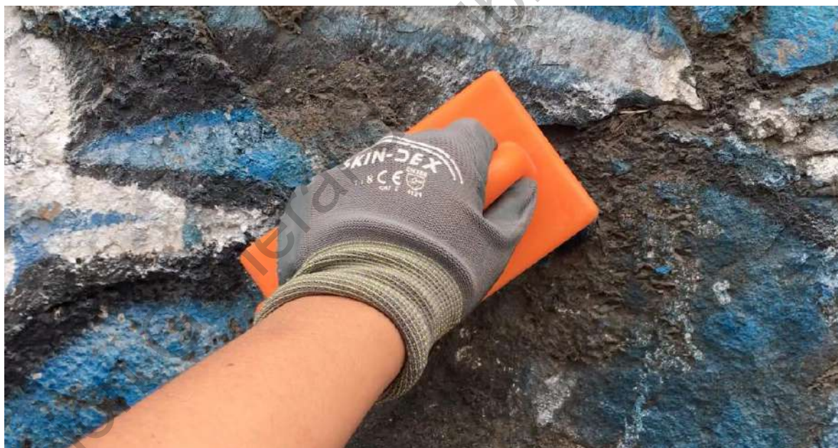
Fotografía 56. Limpieza de muro: autoría propia (tomada en 2019-10-18).
