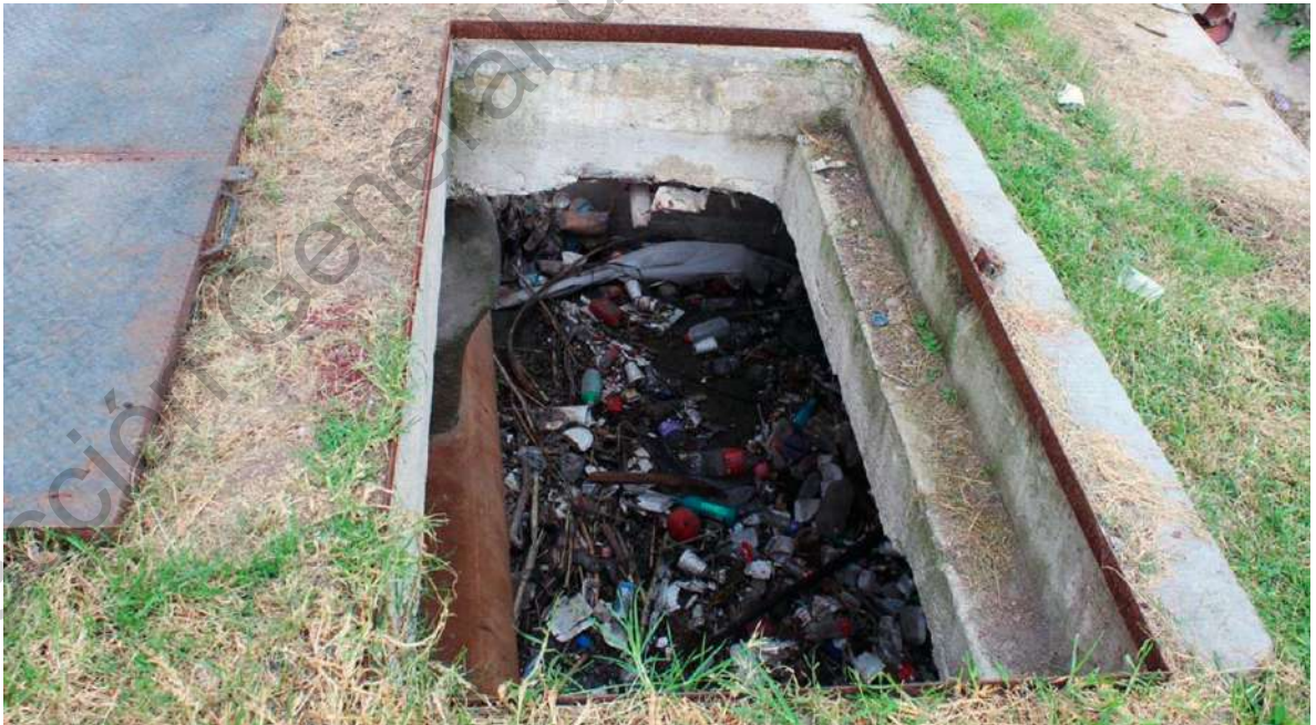
Fotografía 27. Coladeras: autoría propia (tomada en 2018-10-26).
