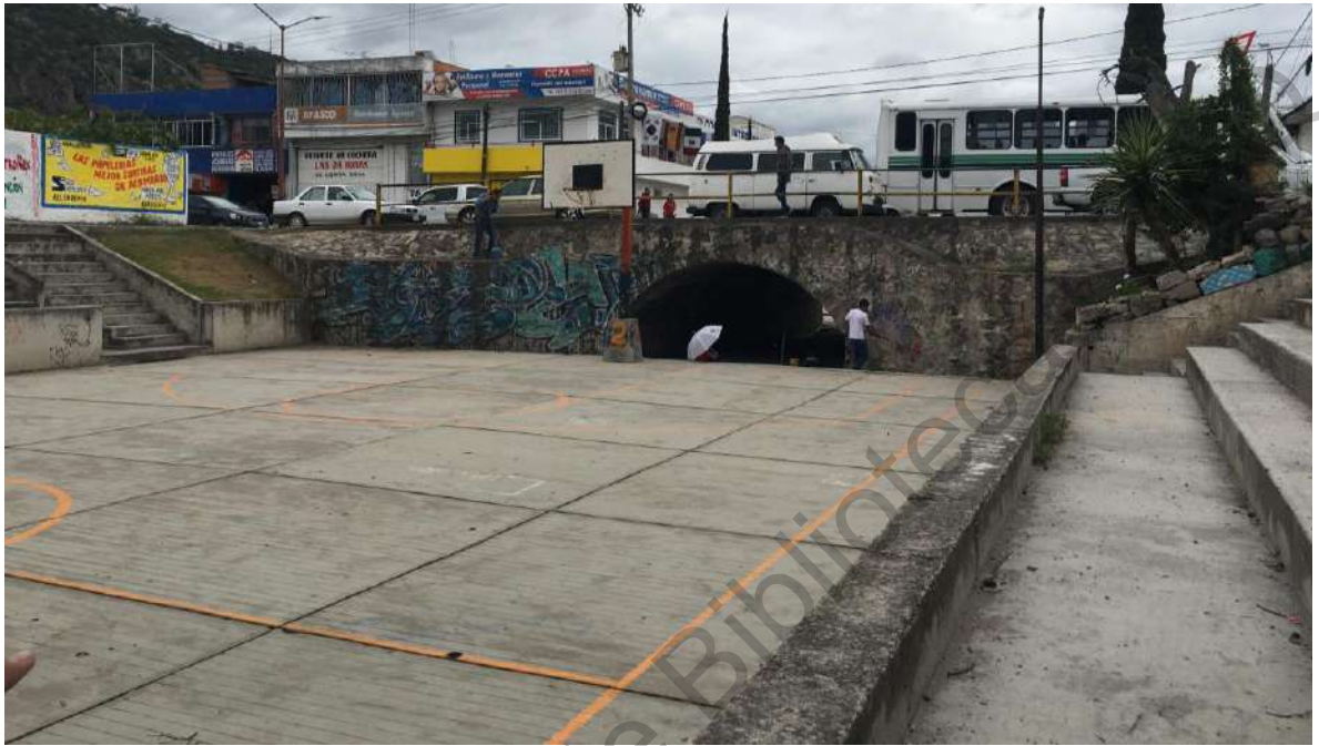
Fotografía 57. Muro puente: autoría propia (tomada en 2019-10-18).
