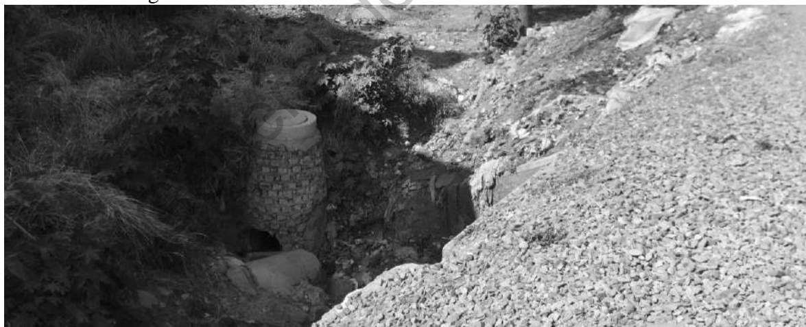
Fotografía 55. Túnel segunda y tercera zona: autoría propia (tomada en 2018-03-27).
