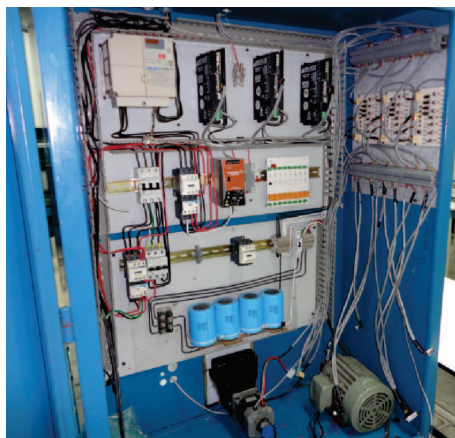
Figura 3.14: Sistema eléctrico de potencia instrumentado.
