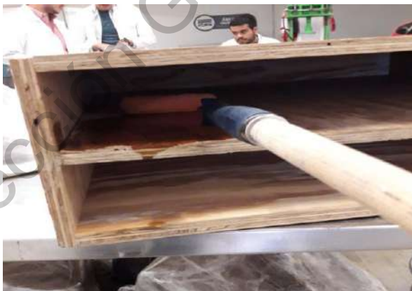
Fig. 53 Aplicación de desmoldante.
