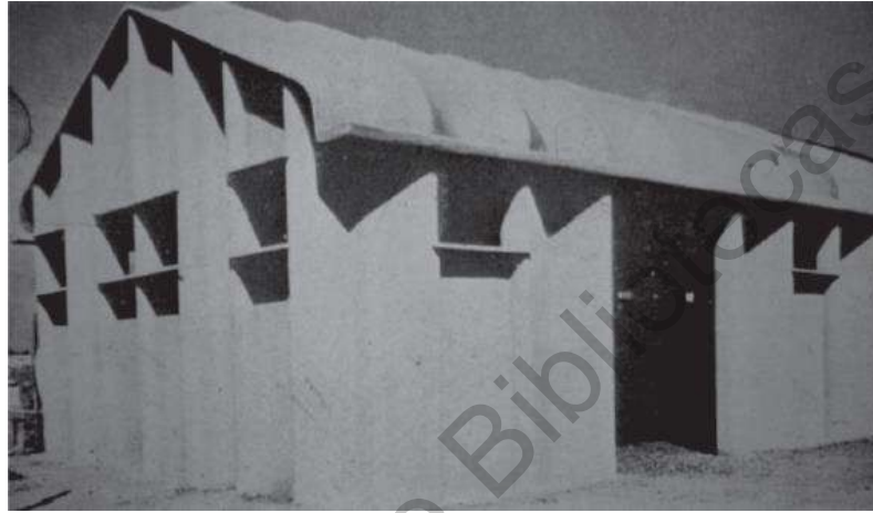
Fig. 3 Tienda de tabaco hecha de ferrocemento en Nervi Bologna, (ACI 549R-18, 2018).
