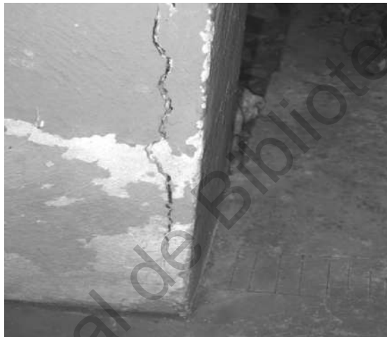
Fig. 2.1 Agrietamiento por corrosión del acero de refuerzo en columna. (Instituto Mexicano del Cemento y del Concreto, A.C., 2001)
