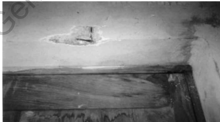
Fig. 2.1 Agrietamiento por corrosión del acero de refuerzo en columna. (Instituto Mexicano del Cemento y del Concreto, A.C., 2001)
