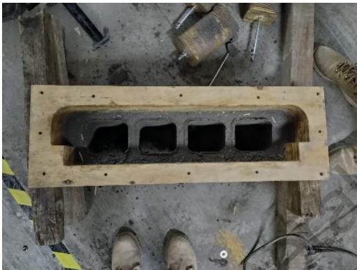
Figura 60: "Retiro de molde" Fuente: Foto tomada por el autor.
