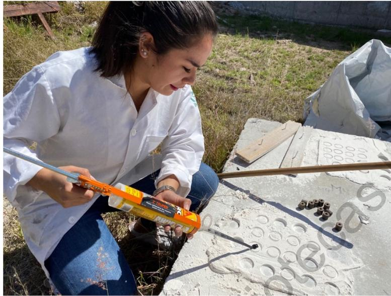
Ilustración 21. Aplicación pegamento epóxico.
