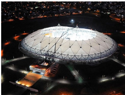
Figura 6.3. Cubierta ligera del estadio “La Plata”, Argentina.
