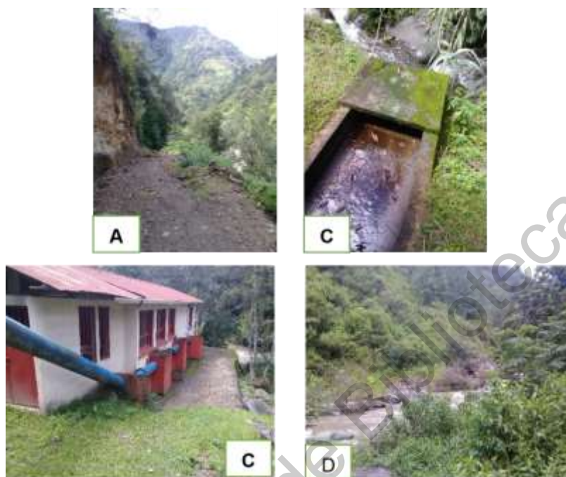
Figura 12: A. Ingreso instalaciones de turbinas, B. Infraestructura expuesta, C. Instalación es de turbinas y D. Río Coatán y Río Chemealón.
