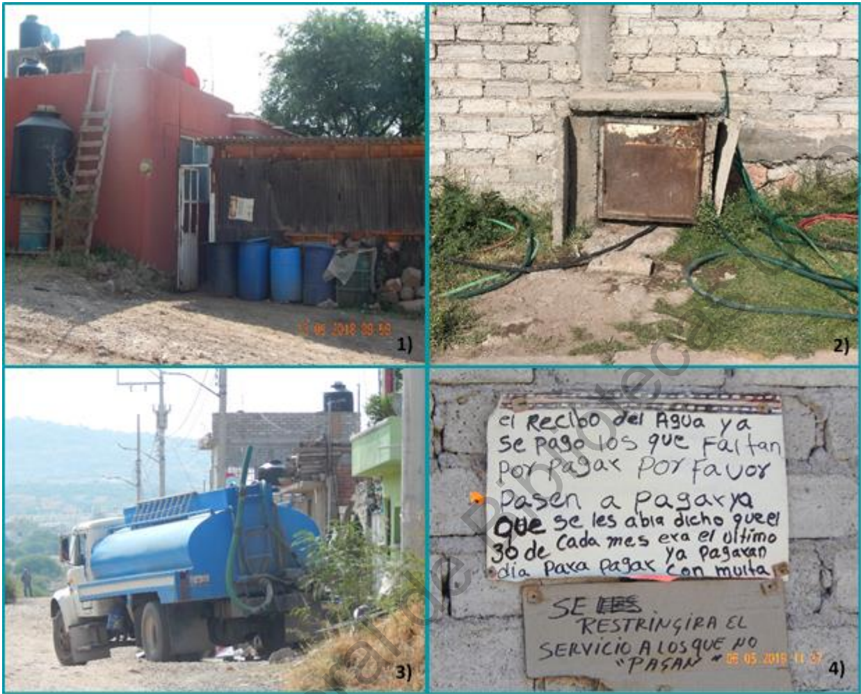
Figura 17. 1) Tambos y tinacos para llenar con pipas en San Juan-Ampliación. 2) Hidrante comunitario de La Joyita. 3) Pipa descargando en Laderas del Salitre. 4) Avisos de pago de cuota en La Joyita. Fotografías por KJOR.
