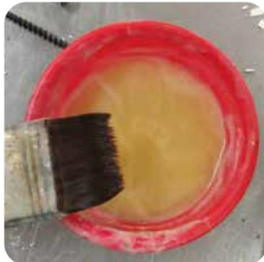
Ilustración 58. Aplicación de desmoldante.
