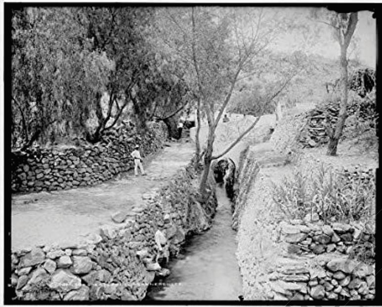
Figura 7. Las galerías filtrantes (socavones) construidos por Cayetano Rubio.
