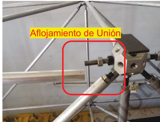
Figura 4. 7 Aflojamiento de Unión.
