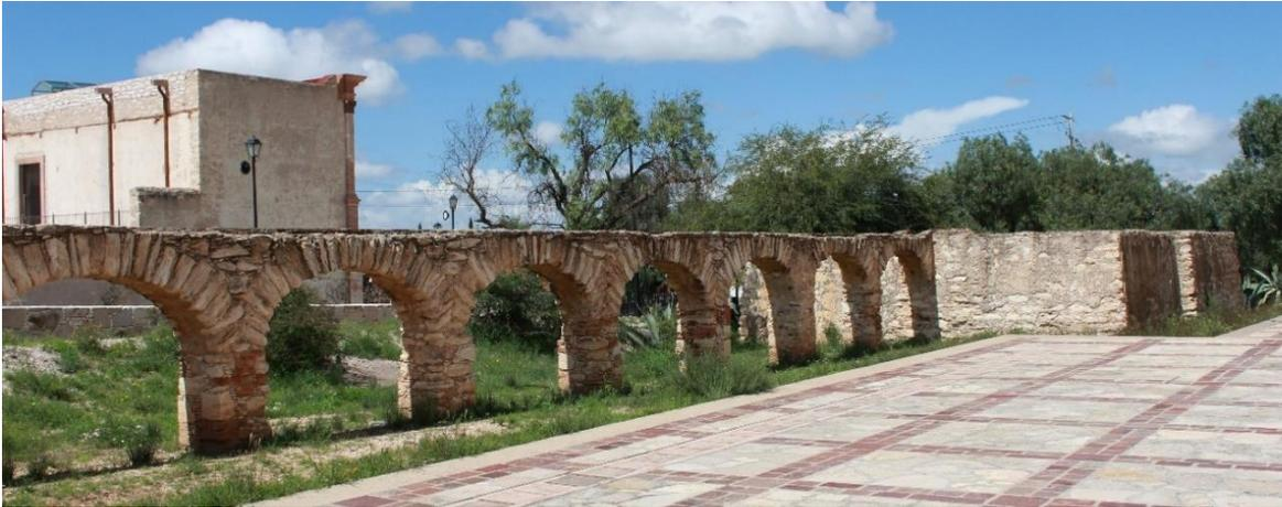
*Imagen 32.* Acueducto y depósitos de Mineral de Pozos, construidos en 1898, sirvieron para conducir y almacenar el agua que se extrajo de diferentes minas. Ubicado al sur de las escuelas Modelo de Artes y Oficios en Ciudad Porfirio Díaz; su construcción es principalmente a base de piedra caliche. (Archivo del autor, julio de 2018).
