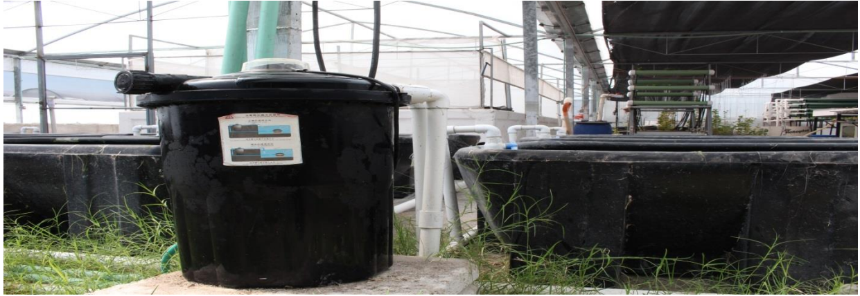
Figura 6. Paso de agua a través de filtro y retorno a tanques de cultivo. Fuente: Elaboración propia.
