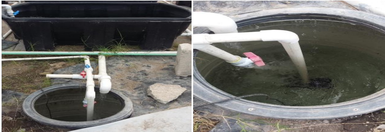
Figura 5. Salida de agua hacia colector y bombeo de agua hacia tanques de cultivo. Fuente: Elaboración propia.
