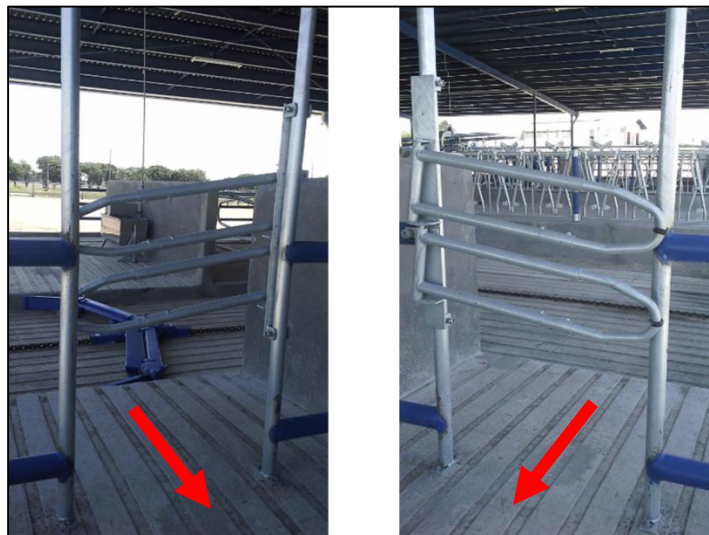
Figura 3 Puerta unidireccional vista por ambos lados
