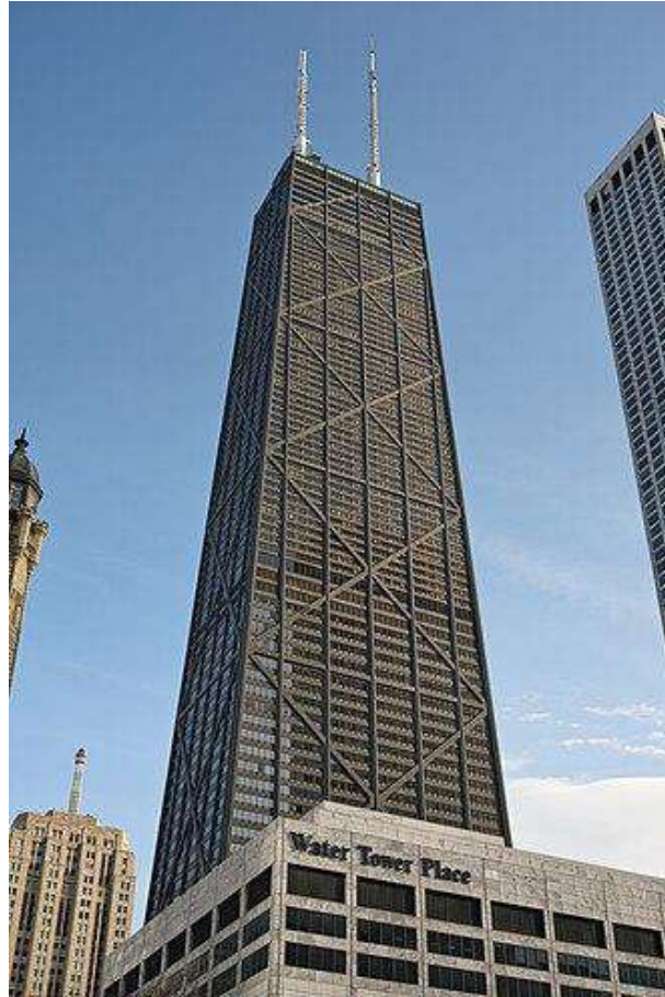
Figura 4. Diagrid John Hancock Center de núcleo diagonalizado.
