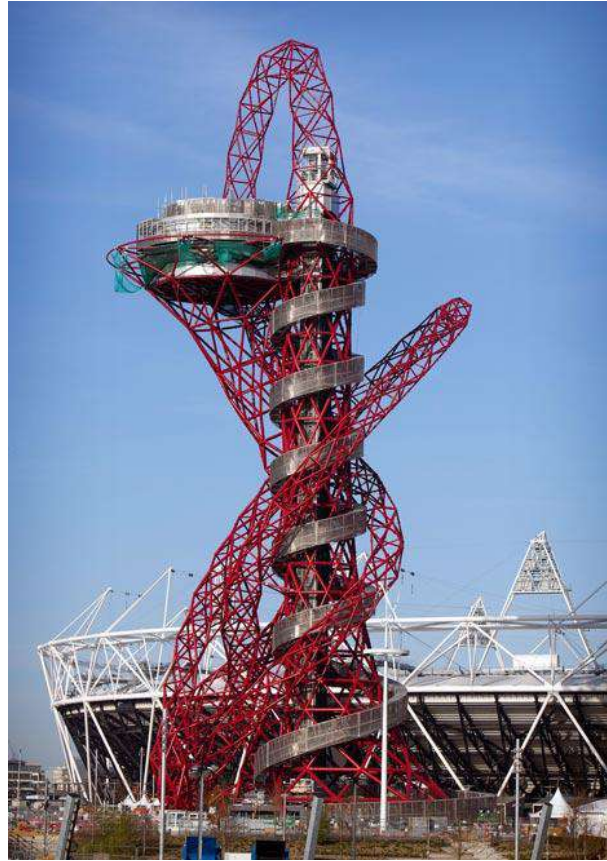
Figura 5. Diagrid Arcelormittal Orbit Tower de configuración AESS.
