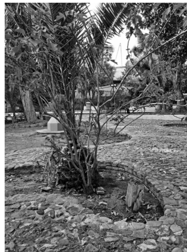
FIG. 16- Vegetación en mal estado. Fuente: Fotografía propia (2025).
