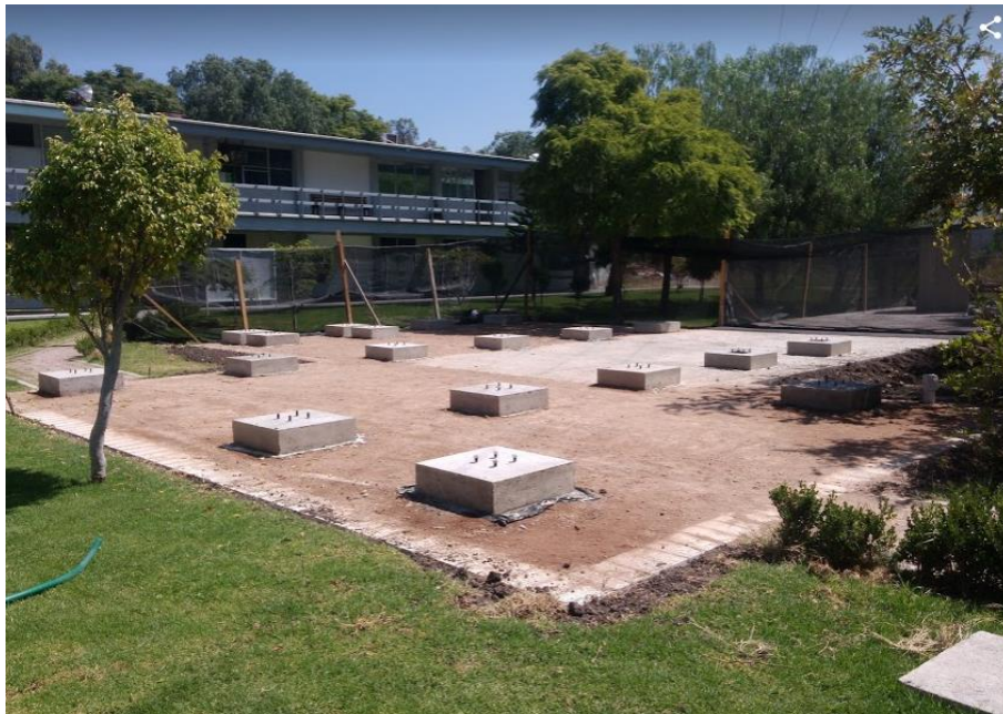
Figura 5-16.- Cimentación terminada al 100% y lista para recibir estructura
