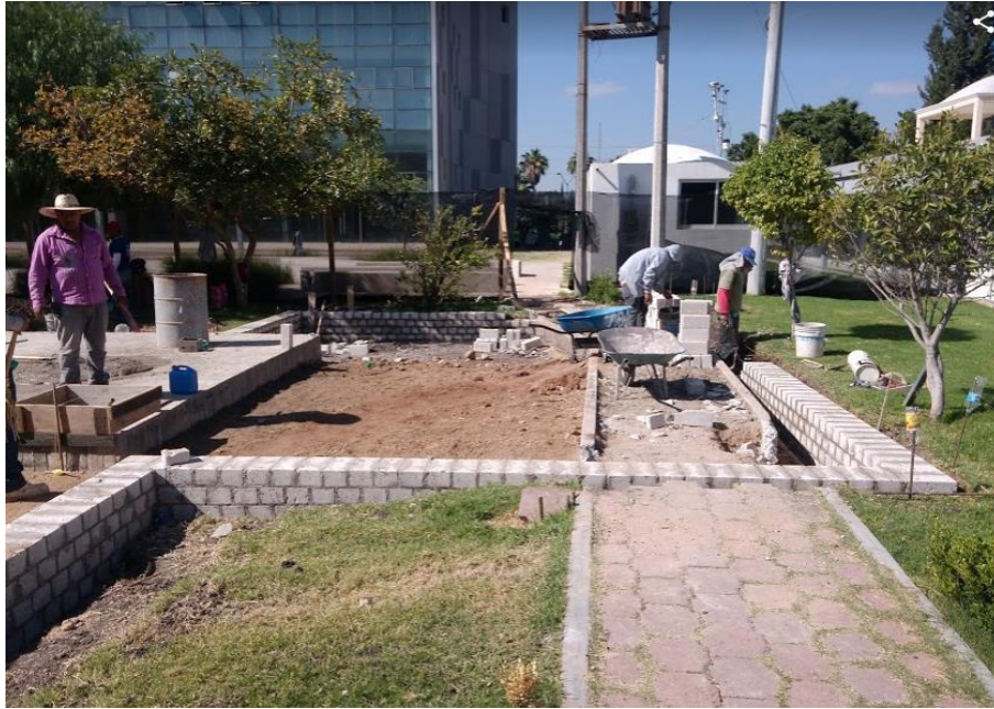
Figura 5-15.- Nivelación de zona donde se construirá la cimentación
