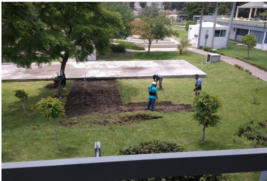
Figura 5-14.- Retiro de jardinería en zona donde se construirá la cimentación.
