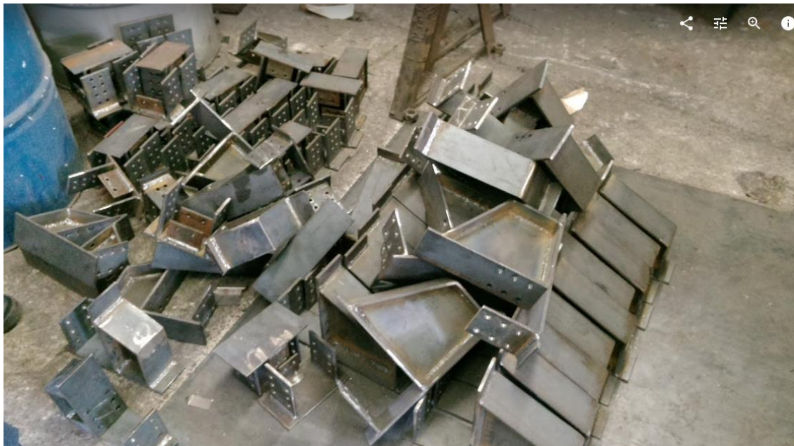
Figura 5-9.- Fabricación de las diferentes conexiones para unir a los elementos estructurales
