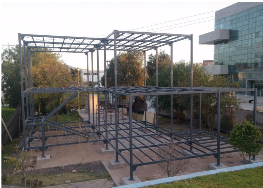
Figura 5-22.- Estructurara ensamblada al 100 %
