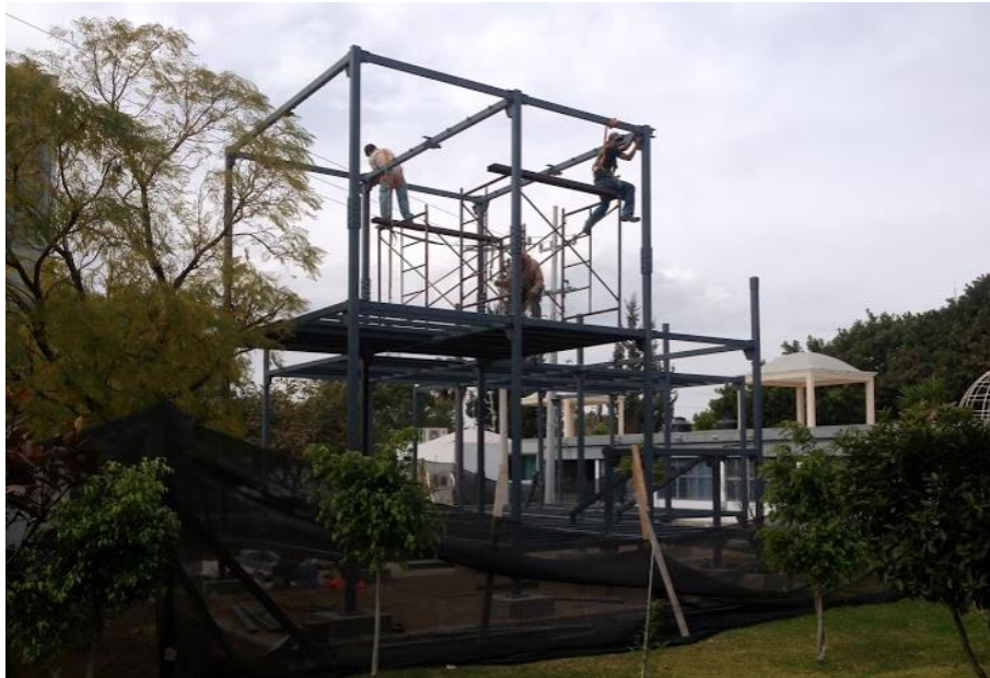
Figura 5-21.- Montaje de últimos elementos de azotea
