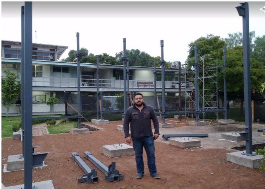
Figura 5-18.- Montaje de elementos verticales tipo columna
