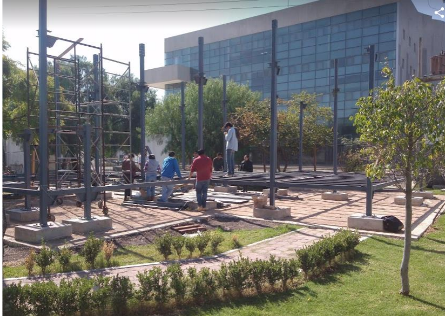
Figura 5-19.- Montaje de sistemas de piso
