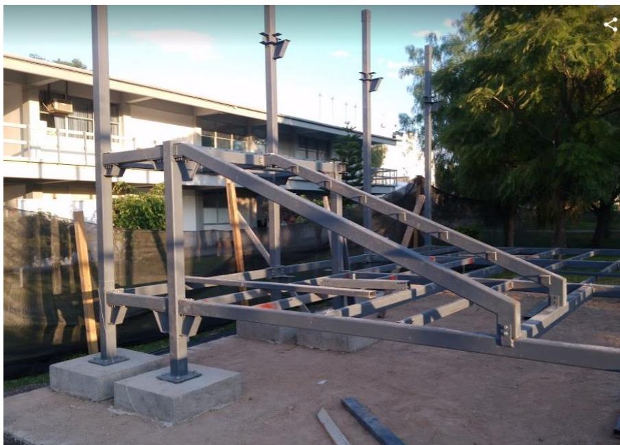
Figura 5-20.- Montaje de escalera
