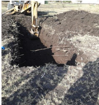
Figura 6-I. Extracción de muestras alteradas.
