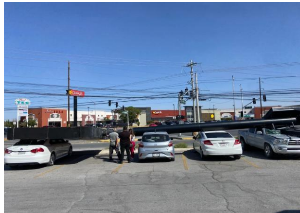
Figura 2.15. Fallas globales en los AEU: a) daño en el tubo mástil ocasionando el colapso de la mampara, extraído de Obinna (2020), b) pandeo en el tubo columna, extraído de Catarino (2024) y c) colapso total producido por un fallo en el anclaje de la cimentación, extraído de Serna (2024).
