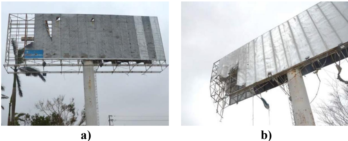
Figura 2.14. Fallas locales en los AEU: a) daños en las láminas de recubrimiento de mampara y b) deformaciones leves o graves en la armadura de la mampara. Extraído de Wen & Xie (2020).
