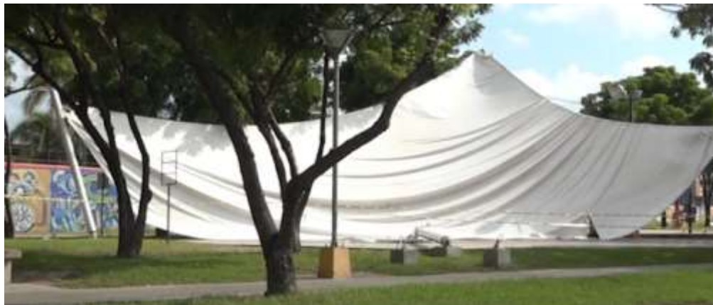
Figura 2.7. Falla en lonaria de parque lineal, extraído de Tvpacifico (2024).
